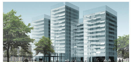
Revitalisierung Haupthaus KfW, Frankfurt
