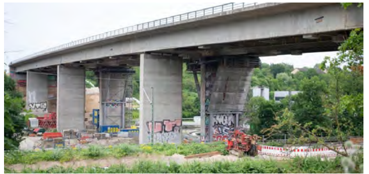
Die Salzachtalbrücke der A66
